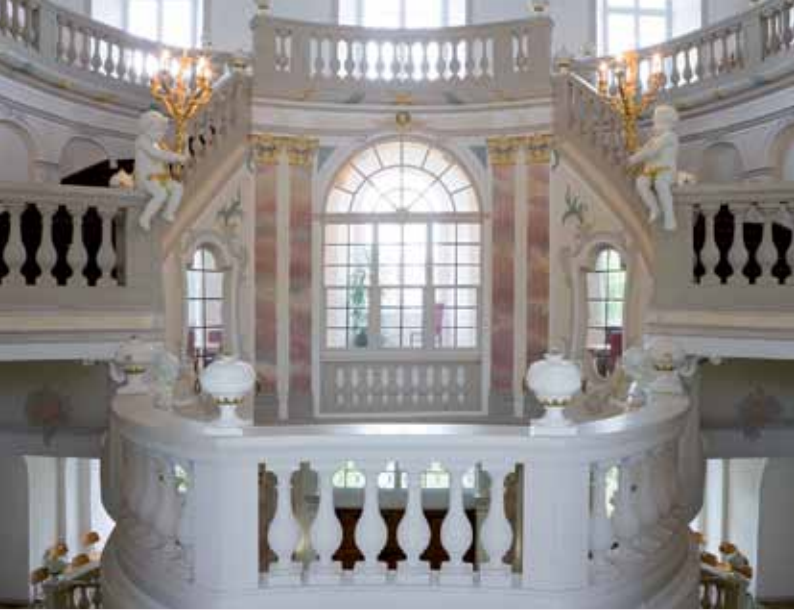
Repräsentative Schlosstreppe Schloss Bad Wurzach – Brandschutzmängel können ggf. durch Brandlastfreiheit kompensiert werden (Foto Stiftung Schloss Bad Wurzach)
