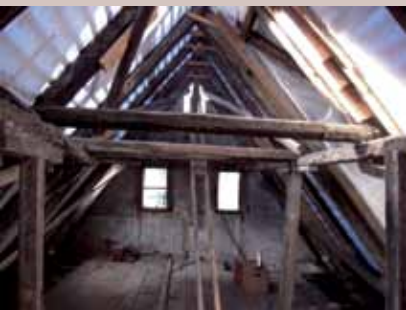
Unausgebauter Dachraum (Foto Stemshorn Architekten)
