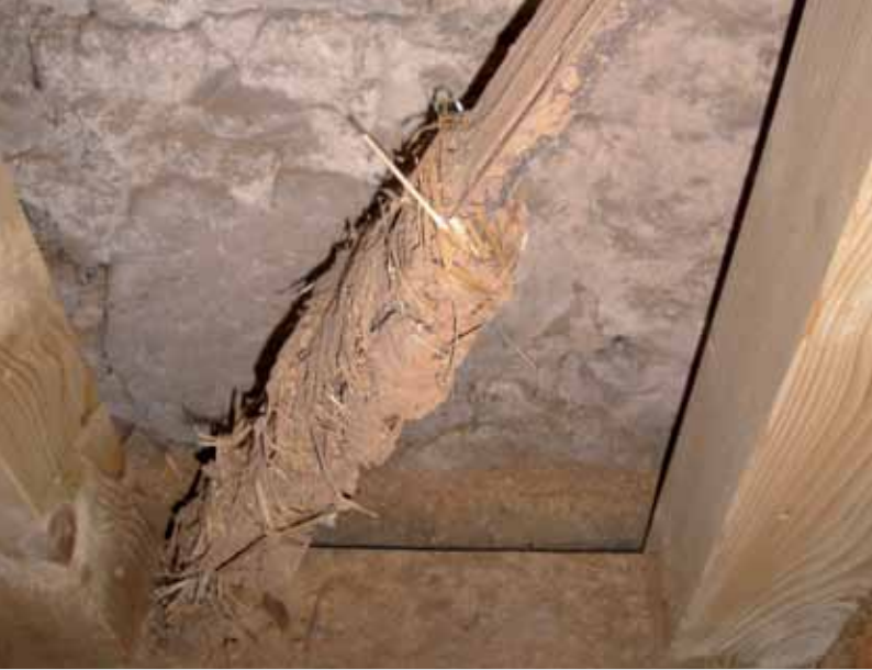
Lehmwickel: nur noch halbseitig von Lehm-/Strohgemisch umwickelte Stake, die zwischen zwei Balken in eine Nut eingeschoben wird
