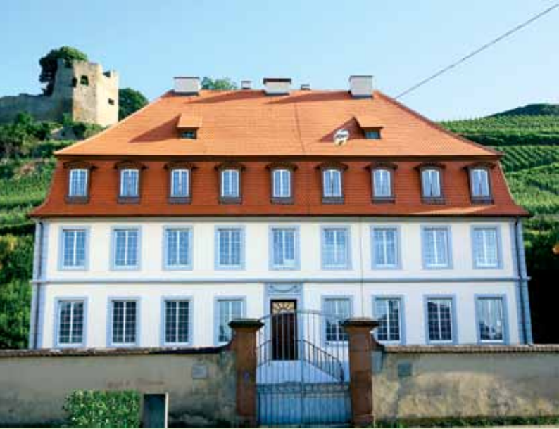
Schloss Hecklingen: Rückseite mit zweitem baulichen Rettungsweg (li.) und die Vorderseite (Fotos Frey Architekten, Freiburg)
