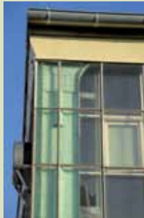
Fabrikgebäude der Firma Steiff in Giengen an der Brenz mit gläserner Vorhangfassade (Baujahr 1903)
