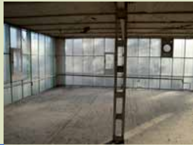
Fabrikgebäude der Firma Steiff in Giengen an der Brenz mit gläserner Vorhangfassade (Baujahr 1903)
