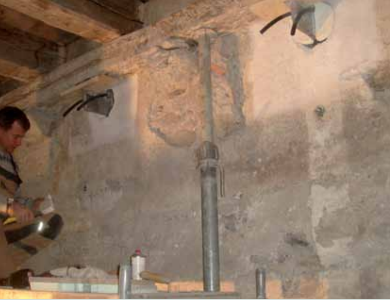
Sanierungsarbeiten im Umfeld des Streichbalkens, dessen Feuerwiderstand in Frage stand
