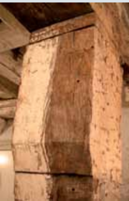
Bebeilter (vermutlich ehemals verputzter) Stützenkopf im Humpisquartier in Ravensburg
