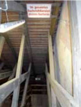
Rettungsweg aus der Turmstube des Freiburger Münsters: Abgang in den Dachstuhl, Weg im Dachstuhl mit historischem Lastkran
