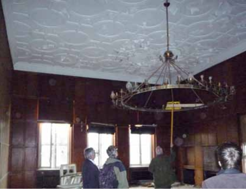
Denkmalrelevante Stuckdecke eines ehemaligen Offizierskasinos in Ludwigsburg
