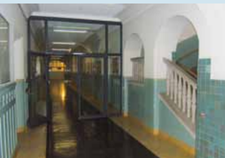
Rauchschutztechnische Binnengliederung und Holzverkleidung an notwendigem Flur in einer Schule
