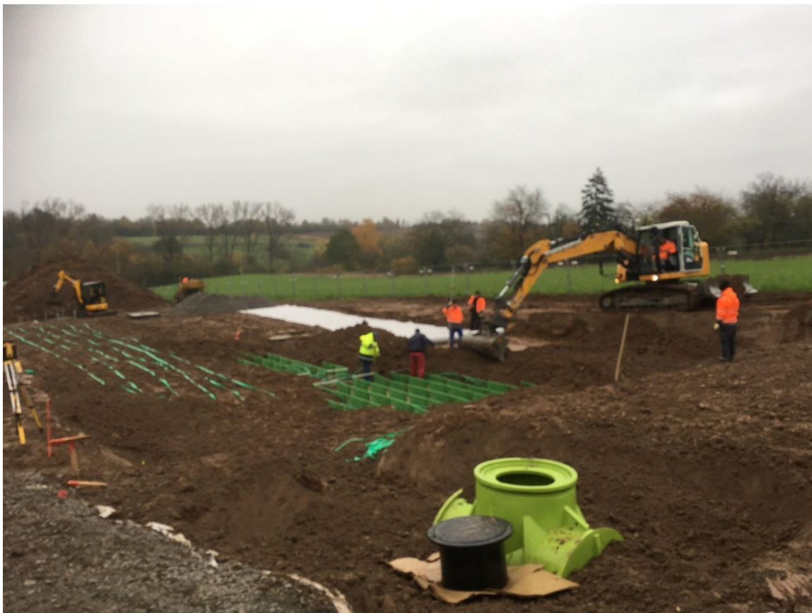
Unter dem neuen Bolzplatz (Ostseite) wurde der Erdwärmetauscher bereits Ende 2024 eingebaut
